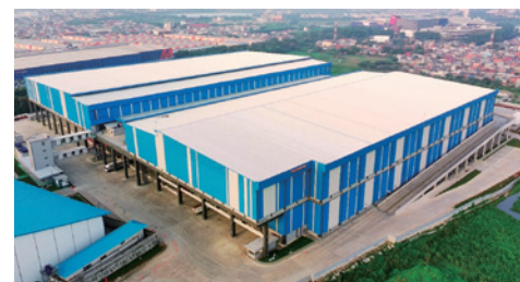
Cella Cakra Logistik Warehouse (賃貸面積:約10.1万㎡)
