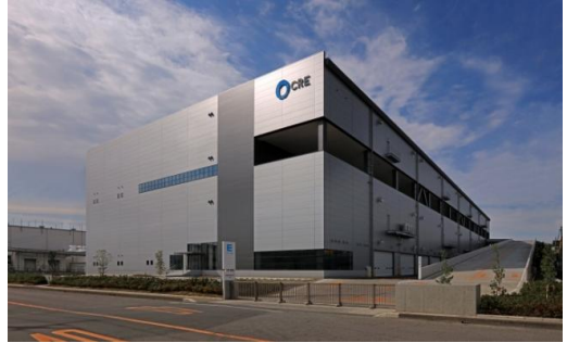
ロジスクエア久喜 2016年6月竣工
