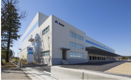
ロジスクエア日高 2015年3月竣工
