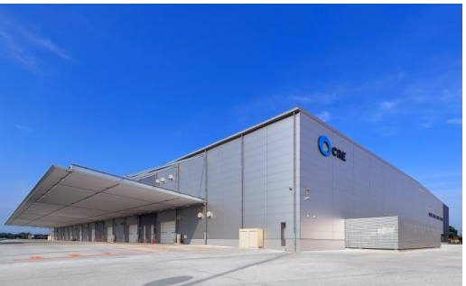
ロジスクエア羽生 2016年7月竣工
