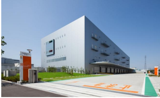
ロジスクエア草加 2013年6月竣工
