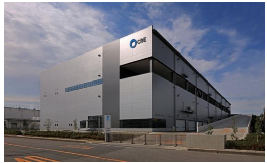
ロジスクエア久喜 2016年6月竣工
