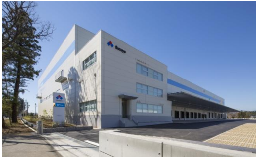
ロジスクエア日高 2015年3月竣工
