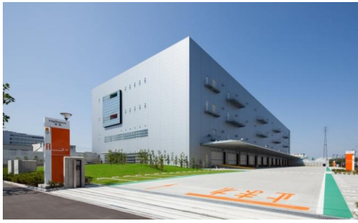
ロジスクエア草加 2013年6月竣工
