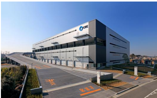
ロジスクエア浦和美園 2017年4月竣工
