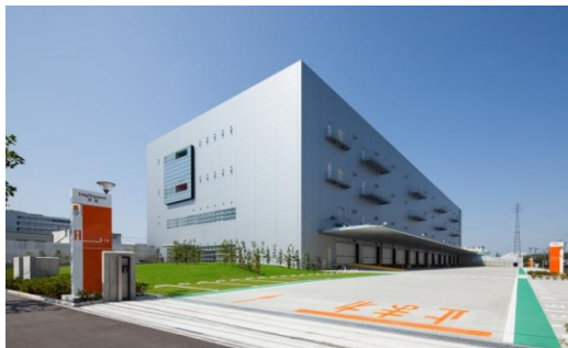
ロジスクエア草加 2013年6月竣工
