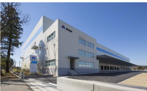
ロジスクエア日高 2015年3月竣工
