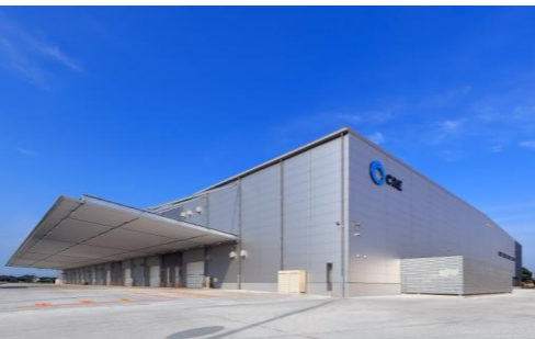
ロジスクエア羽生 2016年7月竣工
