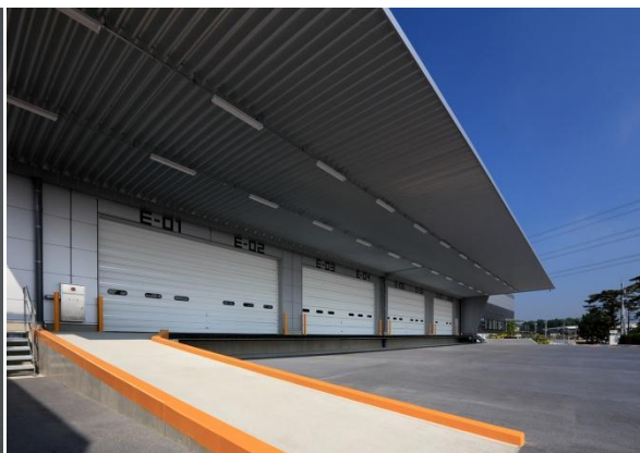
○東側トラックバース
