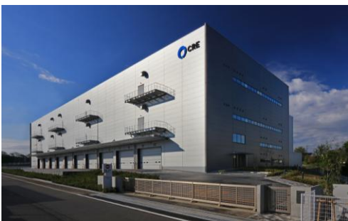
ロジスクエア新座 2017年4月竣工
