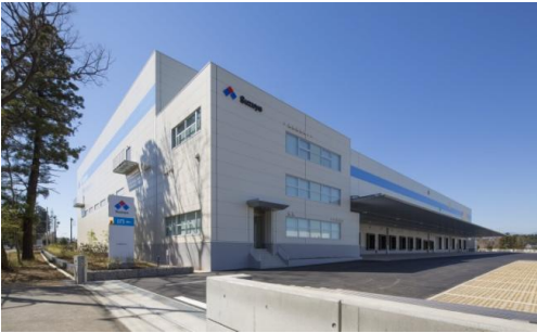
ロジスクエア日高 2015年3月竣工
