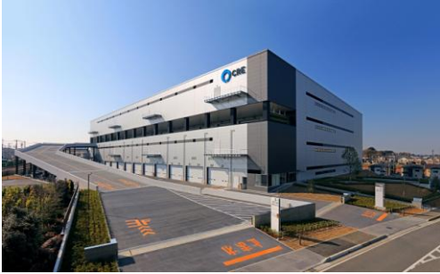
ロジスクエア浦和美園 2017年4月竣工
