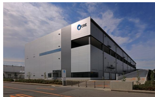
ロジスクエア久喜 2016年6月竣工
