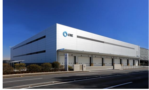
ロジスクエア久喜II 2017年2月竣工
