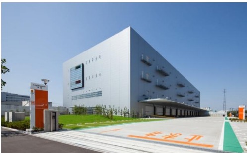
ロジスクエア草加 2013年6月竣工
