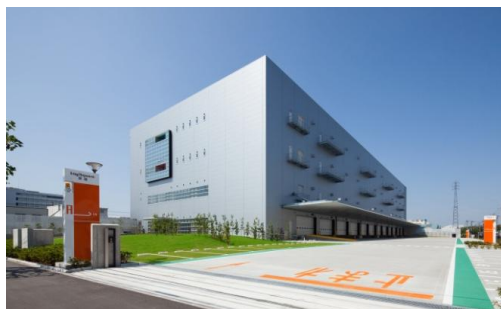
ロジスクエア草加 2013年6月竣工
