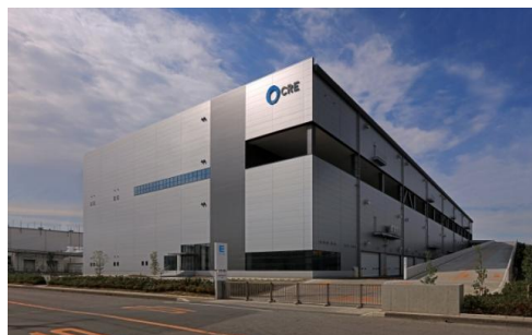
ロジスクエア久喜 2016年6月竣工
