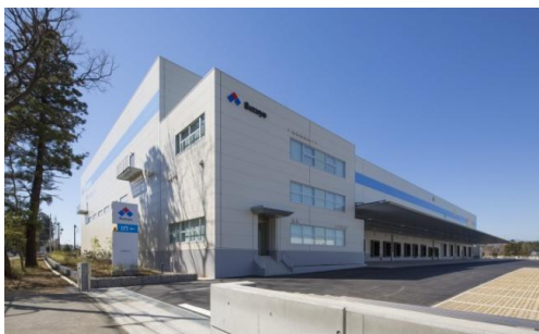
ロジスクエア日高 2015年3月竣工
