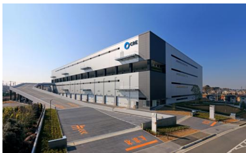
ロジスクエア浦和美園 2017年4月竣工
