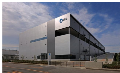
ロジスクエア久喜 2016年6月竣工
