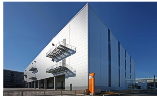
ロジスクエア八潮 2014年1月竣工
