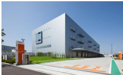
ロジスクエア草加 2013年6月竣工
