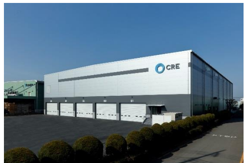
ロジスクエア川越 2018年2月竣工
