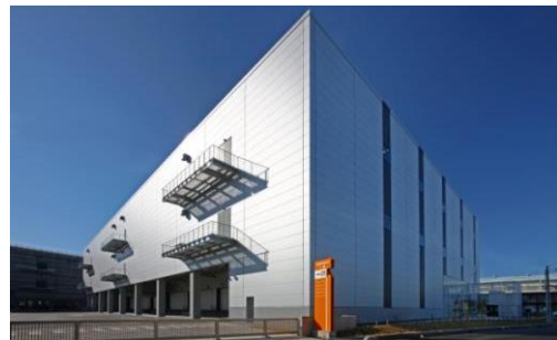
ロジスクエア八潮 2014年1月竣工
