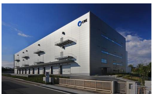
ロジスクエア新座 2017年4月竣工
