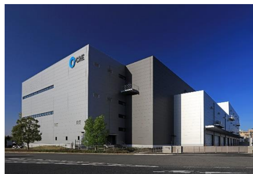
ロジスクエア上尾 2019年4月竣工
