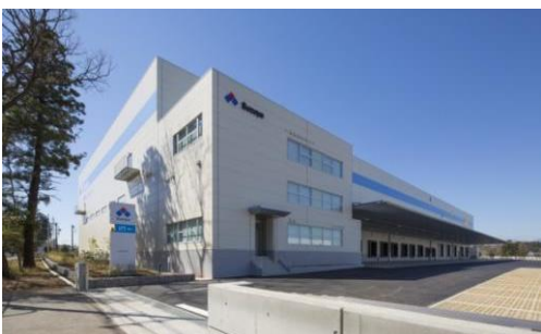
ロジスクエア日高 2015年3月竣工
