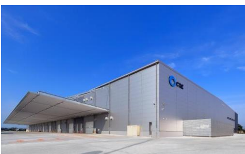
ロジスクエア羽生 2016年7月竣工
