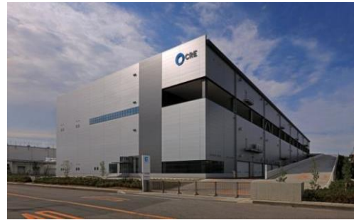
4 ロジスクエア久喜 2016年6月竣工
