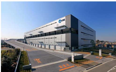
7 ロジスクエア浦和美園 2017年4月竣工
