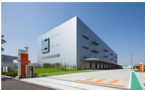
1 ロジスクエア草加 2013年6月竣工
