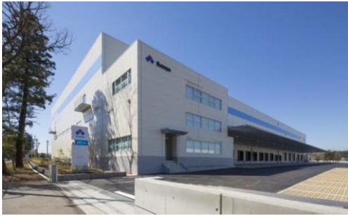
3 ロジスクエア日高 2015年3月竣工
