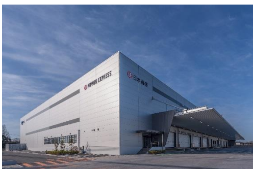
11 ロジスクエア鳥栖 2018年2月竣工
