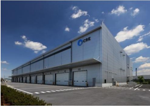
15 ロジスクエア川越Ⅱ 2019年6月竣工
