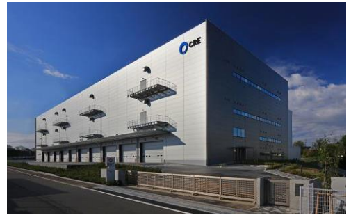
8 ロジスクエア新座 2017年4月竣工
