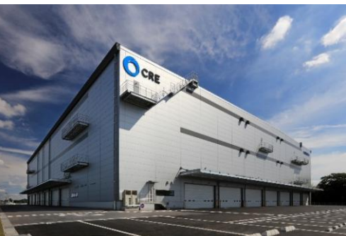
13 ロジスクエア春日部 2018年6月竣工
