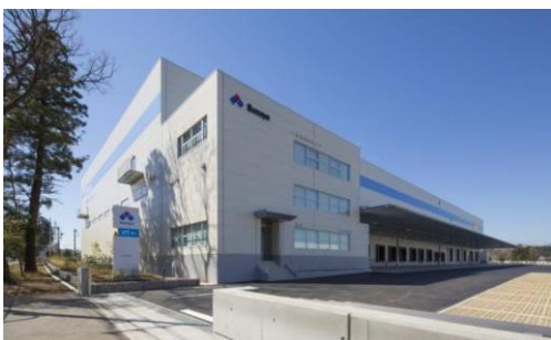
3 ロジスクエア日高 2015年3月竣工
