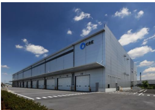
15 ロジスクエア川越Ⅱ 2019年6月竣工
