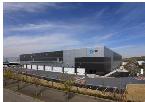
16 ロジスクエア神戸西 2020年4月竣工
