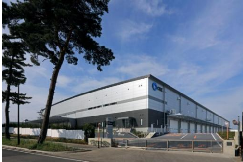
9 ロジスクエア守谷 2017年5月竣工
