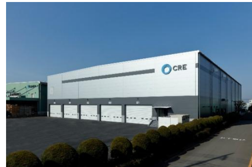
12 ロジスクエア川越 2018年2月竣工
