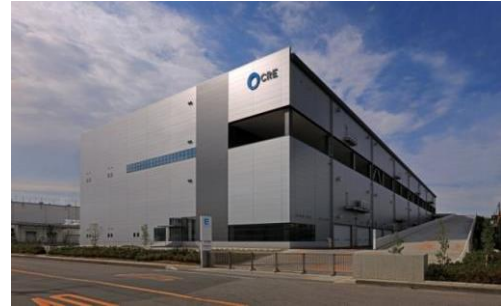
4 ロジスクエア久喜 2016年6月竣工
