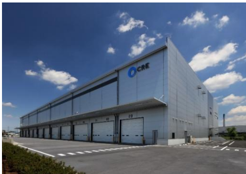
15 ロジスクエア川越Ⅱ 2019年6月竣工
