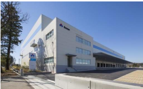
3 ロジスクエア日高 2015年3月竣工
