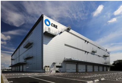
13 ロジスクエア春日部 2018年6月竣工
