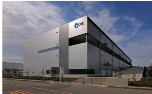
4 ロジスクエア久喜 2016年6月竣工
