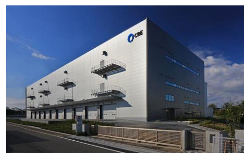
8 ロジスクエア新座 2017年4月竣工
