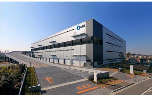
7 ロジスクエア浦和美園 2017年4月竣工
