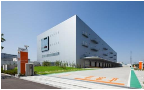
1 ロジスクエア草加 2013年6月竣工
