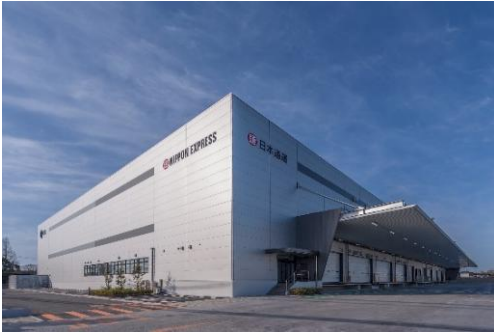
11 ロジスクエア鳥栖 2018年2月竣工
