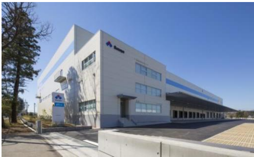
3 ロジスクエア日高 2015年3月竣工
