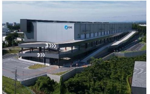
18 ロジスクエア狭山日高（飯能） 2020年6月竣工
