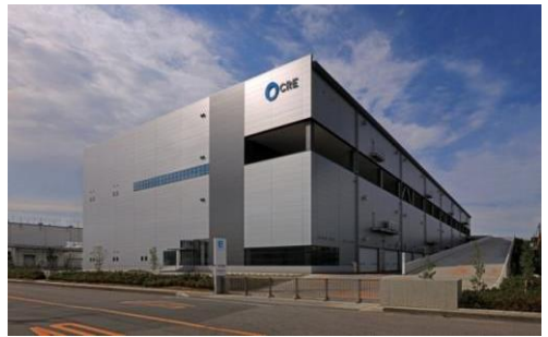
4 ロジスクエア久喜 2016年6月竣工
