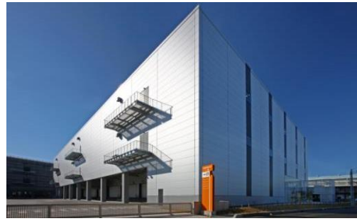
2 ロジスクエア八潮 2014年1月竣工
