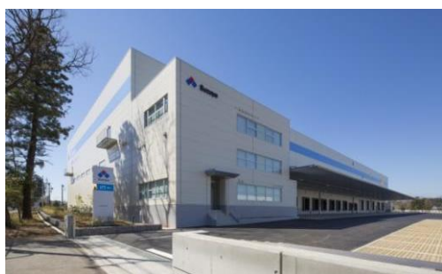
3 ロジスクエア日高 2015年3月竣工
