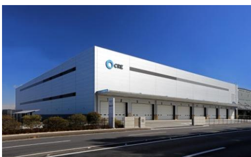
6 ロジスクエア久喜Ⅱ 2017年2月竣工
