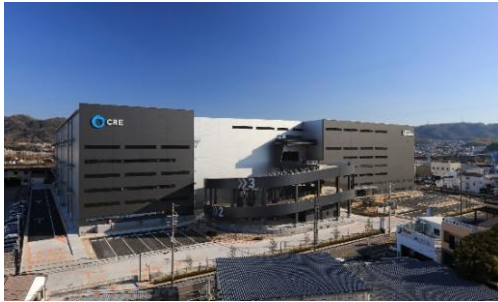
19 ロジスクエア大阪交野 2021年1月竣工
