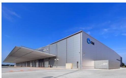
5 ロジスクエア羽生 2016年7月竣工
