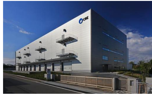
8 ロジスクエア新座 2017年4月竣工
