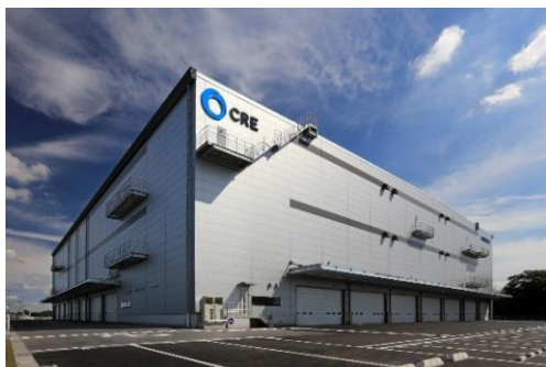
13 ロジスクエア春日部 2018年6月竣工
