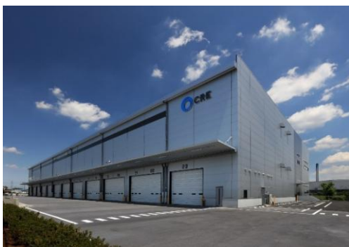
15 ロジスクエア川越Ⅱ 2019年6月竣工
