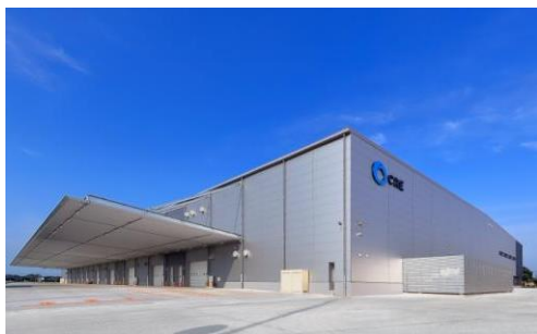
5 ロジスクエア羽生 2016年7月竣工
