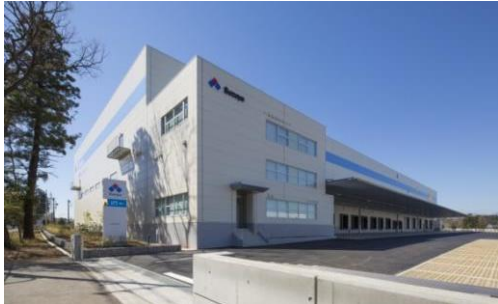
3 ロジスクエア日高 2015年3月竣工
