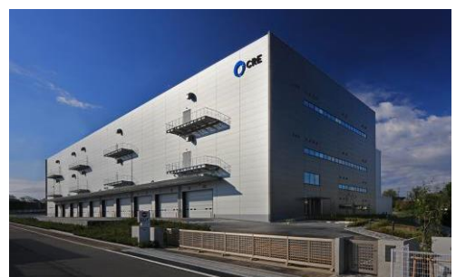
8 ロジスクエア新座 2017年4月竣工
