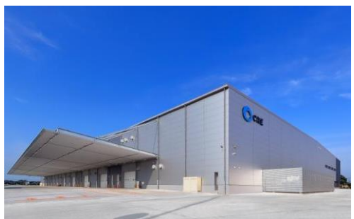
5 ロジスクエア羽生 2016年7月竣工
