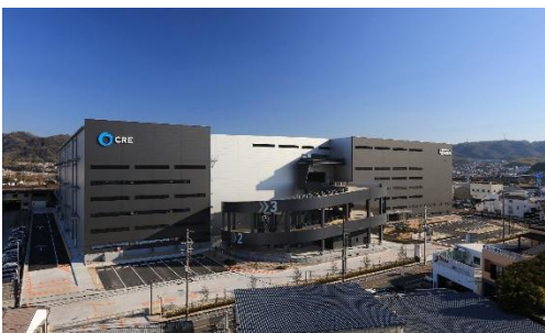
19 ロジスクエア大阪交野 2021年1月竣工
