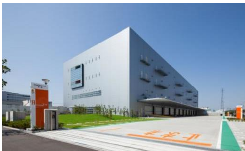
1 ロジスクエア草加 2013年6月竣工
