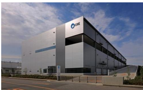
4 ロジスクエア久喜 2016年6月竣工
