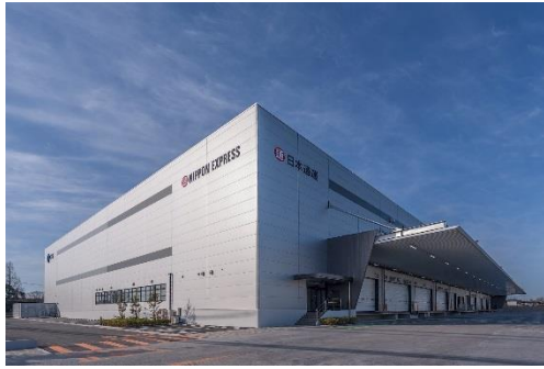
11 ロジスクエア鳥栖 2018年2月竣工
