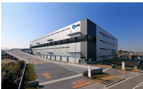
7 ロジスクエア浦和美園 2017年4月竣工
