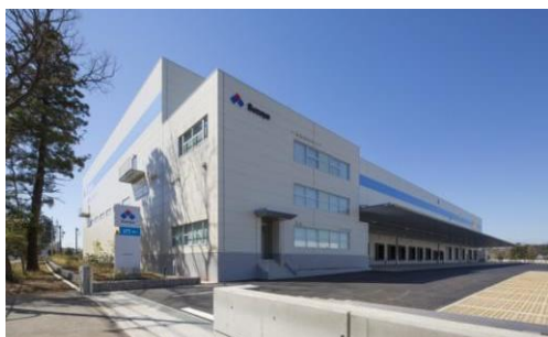
3 ロジスクエア日高 2015年3月竣工
