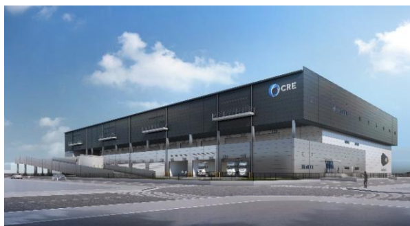
22 ロジスクエア白井 2022年12月竣工予定
