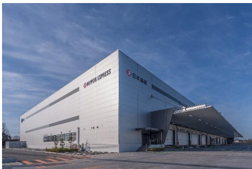
11 ロジスクエア鳥栖 2018年2月竣工
