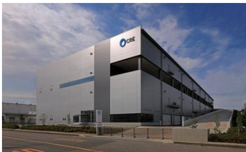
4 ロジスクエア久喜 2016年6月竣工
