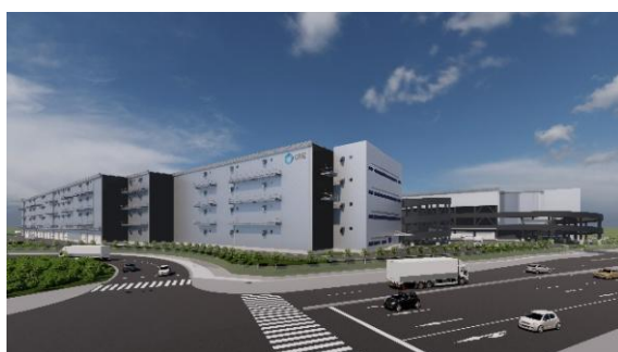
29-31 ロジスクエアふじみ野 (A棟・B棟) 2024年竣工予定
