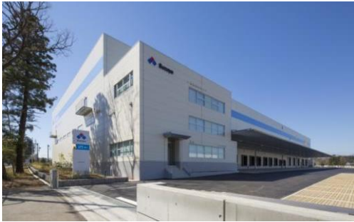
3 ロジスクエア日高 2015年3月竣工
