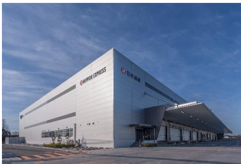
11 ロジスクエア鳥栖 2018年2月竣工
