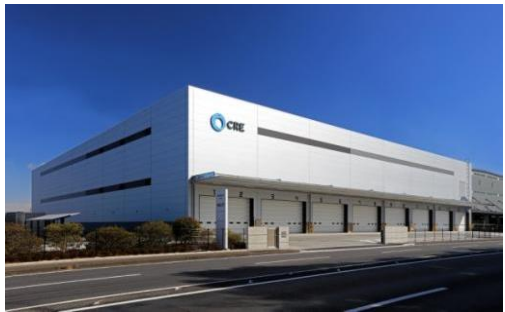
6 ロジスクエア久喜II 2017年2月竣工
