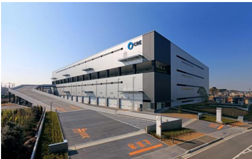
7 ロジスクエア浦和美園 2017年4月竣工
