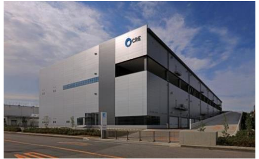
4 ロジスクエア久喜 2016年6月竣工
