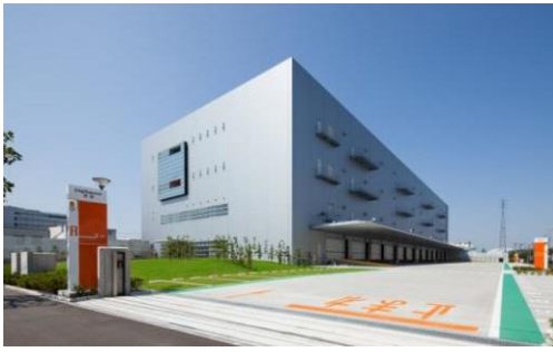
1 ロジスクエア草加 2013年6月竣工
