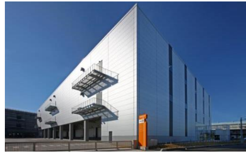
2 ロジスクエア八潮 2014年1月竣工
