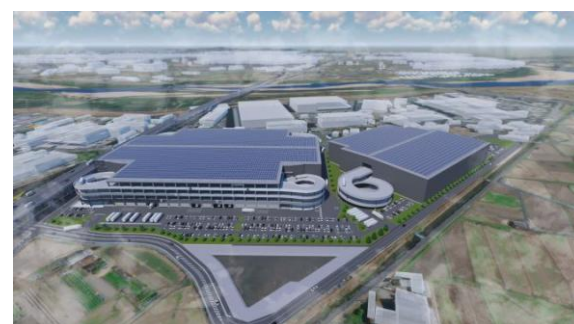
32 ロジスクエア京田辺 A 2025年2月竣工予定 33 ロジスクエア京田辺 B 2026年竣工予定
