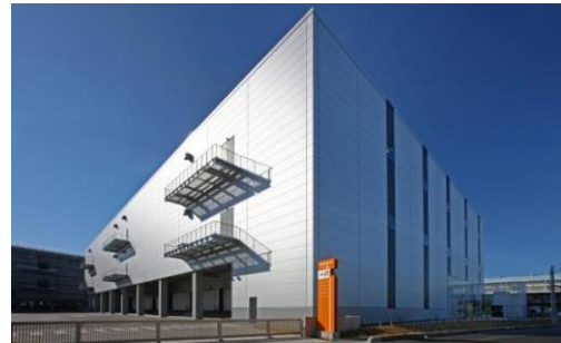
2 ロジスクエア八潮 2014年1月竣工
