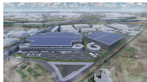
32 ロジスクエア京田辺 A 2025年2月竣工予定 33 ロジスクエア京田辺 B 2026年竣工予定
