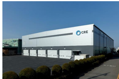
12 ロジスクエア川越 2018年2月竣工
