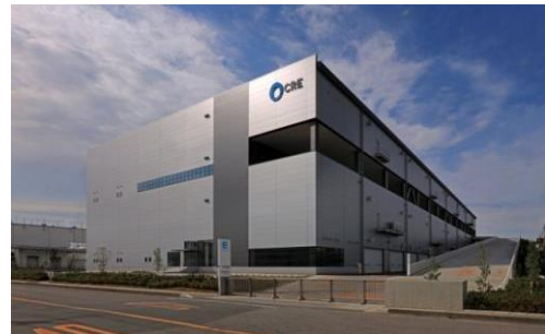
4 ロジスクエア久喜 2016年6月竣工
