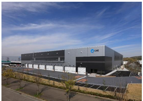
16 ロジスクエア神戸西 2020年4月竣工
