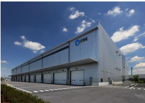
15 ロジスクエア川越II 2019年6月竣工
