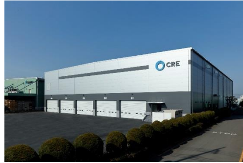
12 ロジスクエア川越 2018年2月竣工
