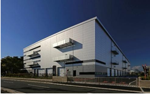
21 ロジスクエア伊丹 2022年11月竣工
