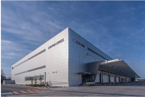
11 ロジスクエア鳥栖 2018年2月竣工
