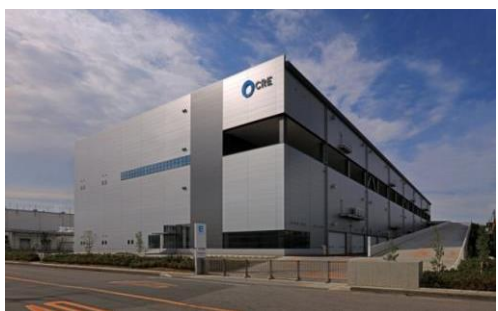
4 ロジスクエア久喜 2016年6月竣工
