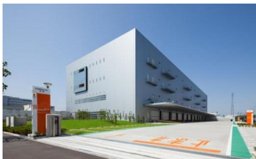
1 ロジスクエア草加 2013年6月竣工
