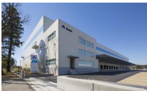
3 ロジスクエア日高 2015年3月竣工
