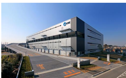
7 ロジスクエア浦和美園 2017年4月竣工
