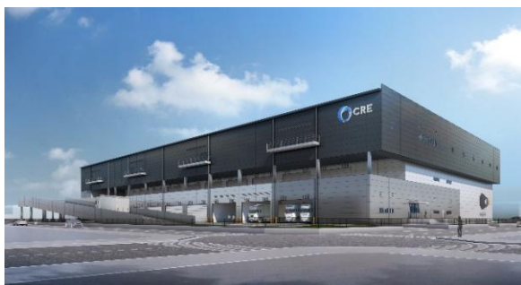
22 ロジスクエア白井 2022年12月竣工予定
