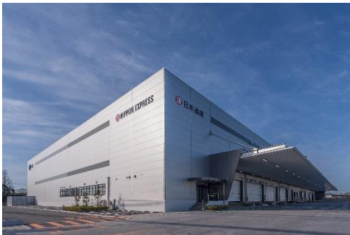
11 ロジスクエア鳥栖 2018年2月竣工
