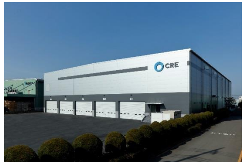
12 ロジスクエア川越 2018年2月竣工
