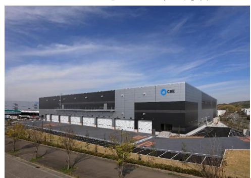
16 ロジスクエア神戸西 2020年4月竣工
