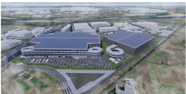
32 ロジスクエア京田辺 A 2025年2月竣工予定 33 ロジスクエア京田辺 B 2026年竣工予定
