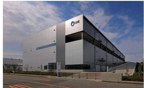
4 ロジスクエア久喜 2016年6月竣工
