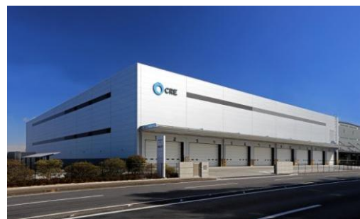
6 ロジスクエア久喜Ⅱ 2017年2月竣工
