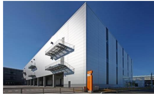
2 ロジスクエア八潮 2014年1月竣工
