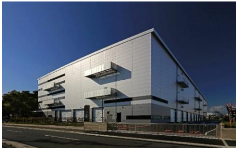
21 ロジスクエア伊丹 2022年11月竣工
