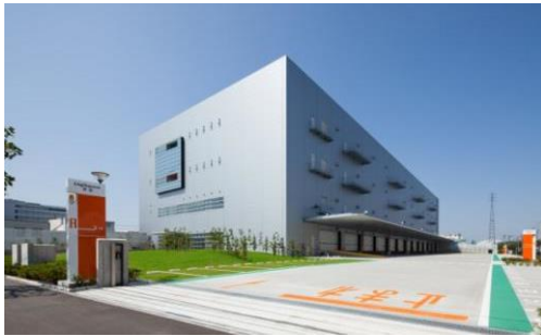
1 ロジスクエア草加 2013年6月竣工
