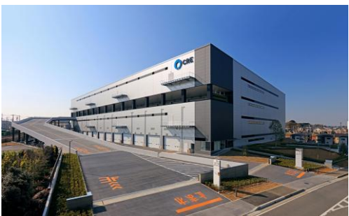
7 ロジスクエア浦和美園 2017年4月竣工
