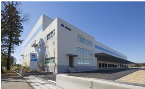
3 ロジスクエア日高 2015年3月竣工
