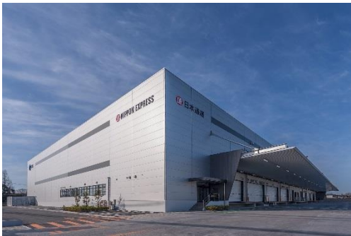
11 ロジスクエア鳥栖 2018年2月竣工
