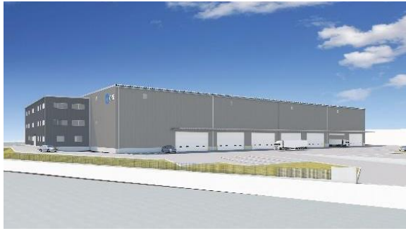
34 ロジスクエア掛川 2024年1月竣工予定
