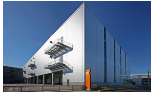
2 ロジスクエア八潮 2014年1月竣工
