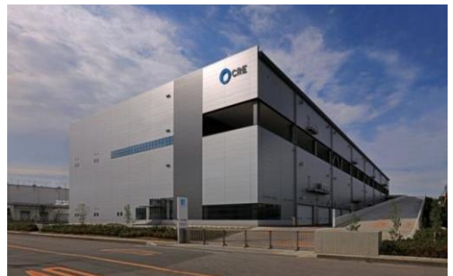
4 ロジスクエア久喜 2016年6月竣工
