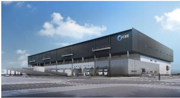
22 ロジスクエア白井 2022年12月竣工予定
