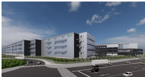
29 ロジスクエアふじみ野A 2024年1月竣工予定 30 ロジスクエアふじみ野B 2024年10月竣工予定
