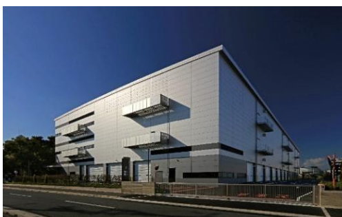
21 ロジスクエア伊丹 2022年11月竣工
