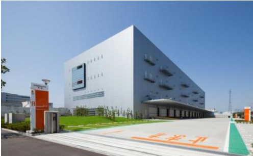
1 ロジスクエア草加 2013 年 6 月竣工
