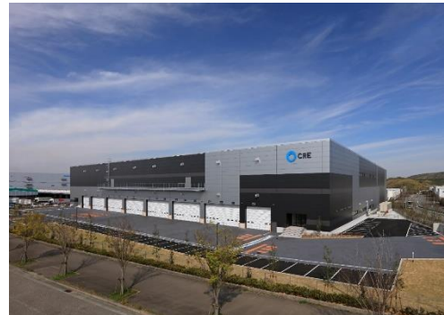
16 ロジスクエア神戸西 2020年4月竣工
