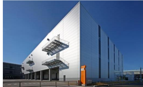
2 ロジスクエア八潮 2014 年 1 月竣工
