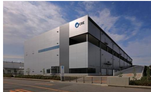
4 ロジスクエア久喜 2016 年 6 月竣工
