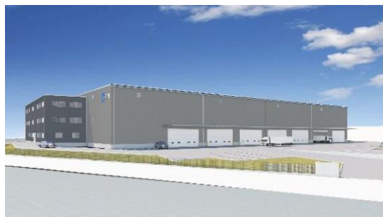
34 ロジスクエア掛川 2024年1月竣工予定
