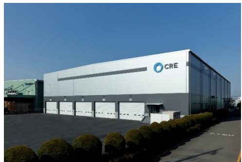
12 ロジスクエア川越 2018年2月竣工
