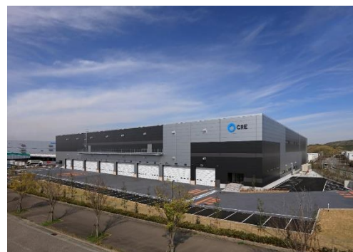
16 ロジスクエア神戸西 2020年4月竣工
