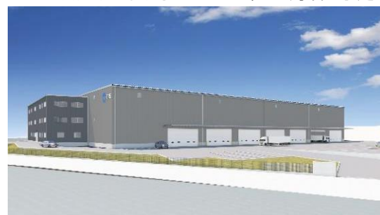
34 ロジスクエア掛川 2024年1月竣工予定
