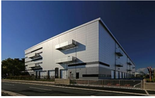
21 ロジスクエア伊丹 2022年11月竣工
