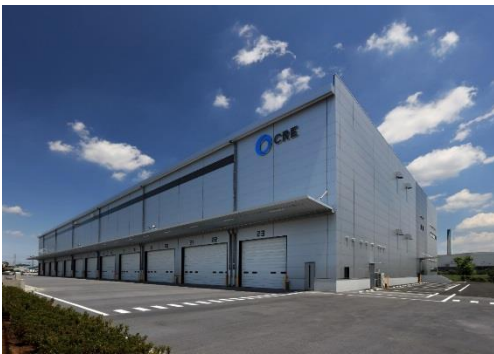
15 ロジスクエア川越Ⅱ 2019年6月竣工
