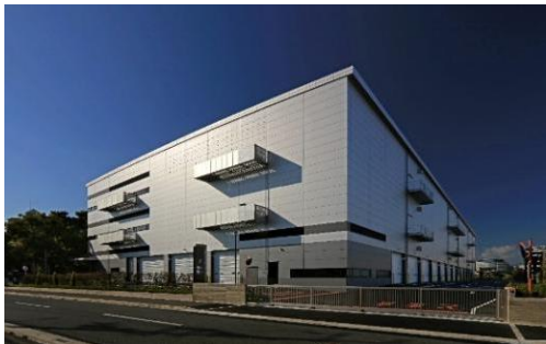
21 ロジスクエア伊丹 2022年11月竣工
