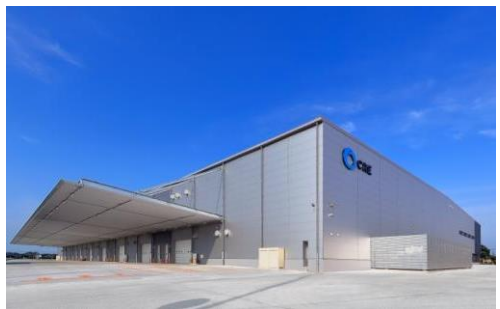
5 ロジスクエア羽生 2016年7月竣工
