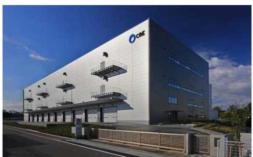
8 ロジスクエア新座 2017年4月竣工
