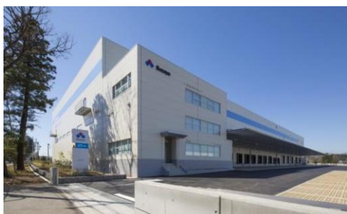
3 ロジスクエア日高 2015年3月竣工
