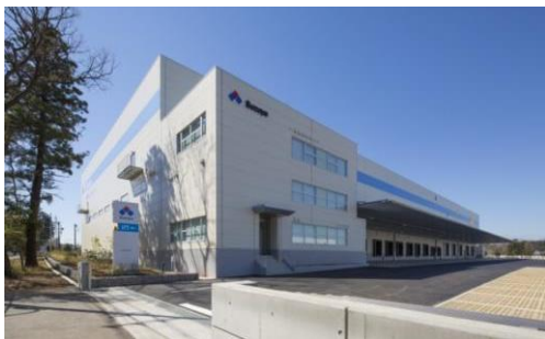
3 ロジスクエア日高 2015年3月竣工
