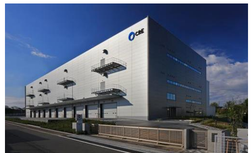
8 ロジスクエア新座 2017年4月竣工
