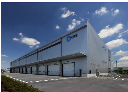
15 ロジスクエア川越Ⅱ 2019年6月竣工
