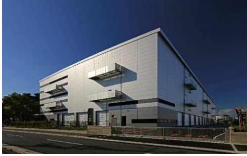
21 ロジスクエア伊丹 2022年11月竣工
