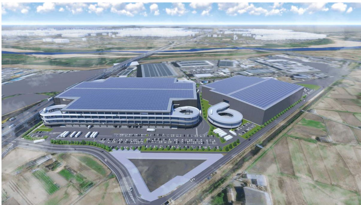
<ロジスクエア京田辺 プロジェクト全景 ※左側がロジスクエア京田辺A、右側がロジスクエア京田辺B>
