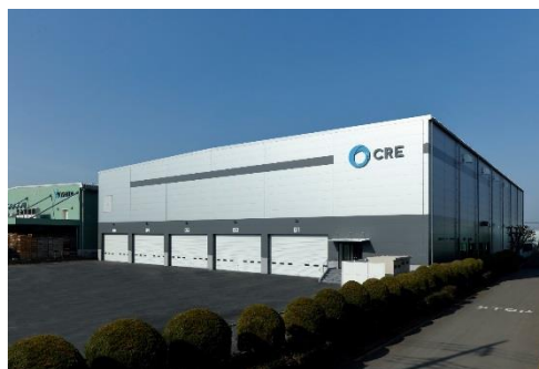
12 ロジスクエア川越 2018年2月竣工
