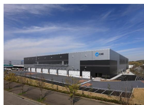
16 ロジスクエア神戸西 2020年4月竣工
