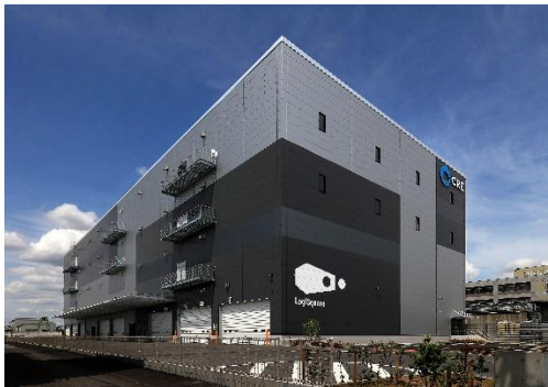
25 ロジスクエア松戸 2023年5月竣工
