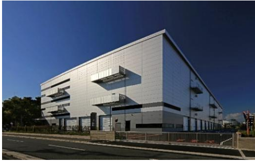
21 ロジスクエア伊丹 2022年11月竣工
