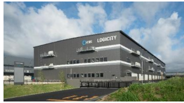
32 ロジシティ小郡 2024年7月竣工
