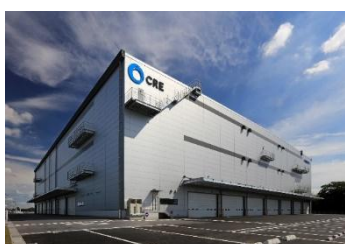
13 ロジスクエア春日部 2018年6月竣工
