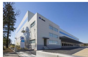
3 ロジスクエア日高 2015年3月竣工
