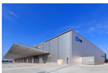
5 ロジスクエア羽生 2016年7月竣工
