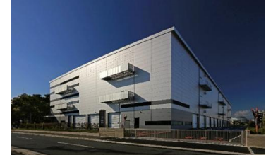
21 ロジスクエア伊丹 2022年11月竣工
