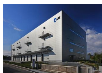
8 ロジスクエア新座 2017年4月竣工
