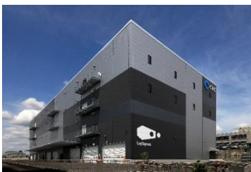
25 ロジスクエア松戸 2023年5月竣工
