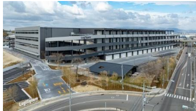
35 ロジスクエア京田辺 A 2025年2月竣工
