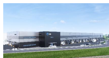
9 ロジスクエア鳥栖Ⅲ 2027 年 4 月竣工予定
