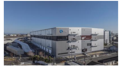
36 ロジスクエア名古屋みなと 2025年12月竣工
