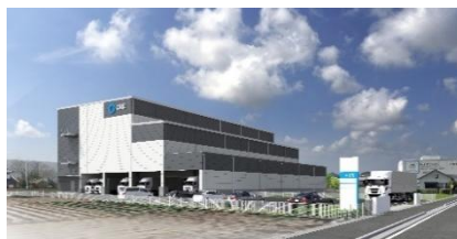
5 ロジスクエア久喜Ⅲ 竣工時期未定
