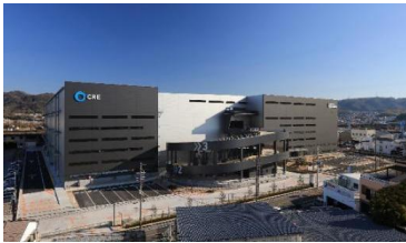
19 ロジスクエア大阪交野 2021年1月竣工
