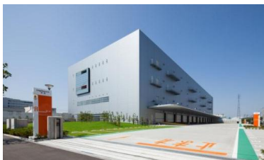
1 ロジスクエア草加 2013年6月竣工
