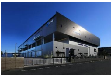
22 ロジスクエア白井 2022年12月竣工
