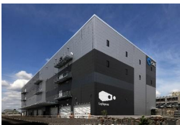
25 ロジスクエア松戸 2023 年 5 月竣工
