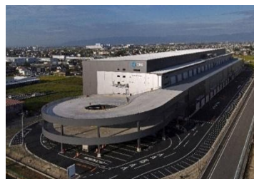
26 ロジスクエアアノ宮 2023 年 9 月竣工
