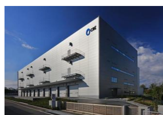
8 ロジスクエア新座 2017 年 4 月竣工
