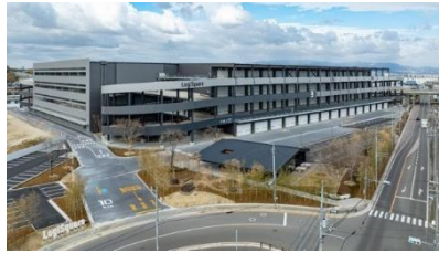
35 ロジスクエア京田辺 A 2025 年 2 月竣工
