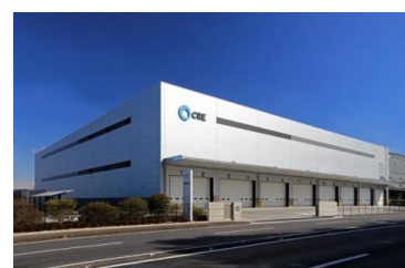
6 ロジスクエア久喜Ⅱ 2017 年 2 月竣工
