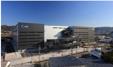
19 ロジスクエア大阪交野 2021 年 1 月竣工
