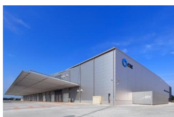
5 ロジスクエア羽生 2016 年 7 月竣工
