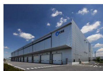
15 ロジスクエア川越Ⅱ 2019 年 6 月竣工
