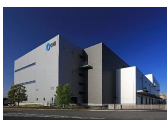
14 ロジスクエア上尾 2019 年 4 月竣工
