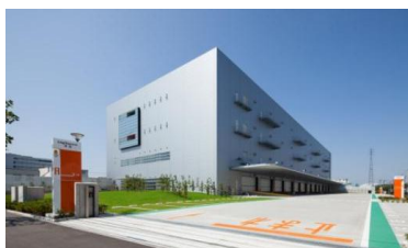
1 ロジスクエア草加 2013 年 6 月竣工
