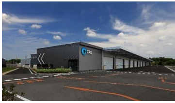
31 ロジスクエア成田 2024 年 5 月竣工
