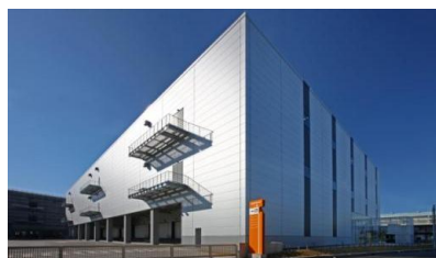
2 ロジスクエア八潮 2014 年 1 月竣工
