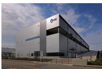
4 ロジスクエア久喜 2016 年 6 月竣工
