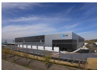
16 ロジスクエア神戸西 2020年4月竣工
