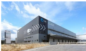
29 ロジスクエア福岡小郡 2024年2月竣工
