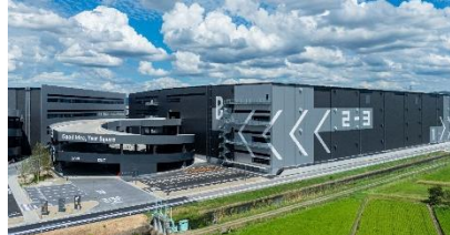
38 ロジスクエア京田辺 B 2026 年 8 月竣工
