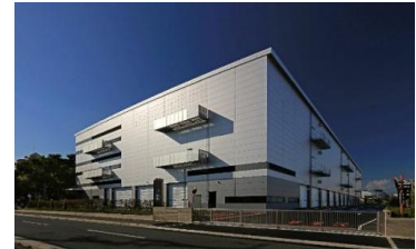
21 ロジスクエア伊丹 2022 年 11 月竣工
