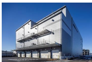
37 ロジスクエア厚木南 2026 年 1 月竣工
