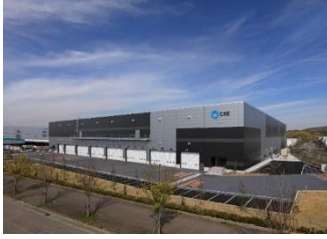
16 ロジスクエア神戸西 2020 年 4 月竣工
